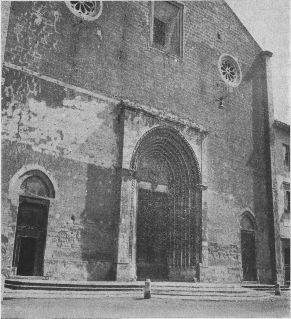
FIG. 8 — Orvieto - Chiesa di S. Francesco, Facciata .
